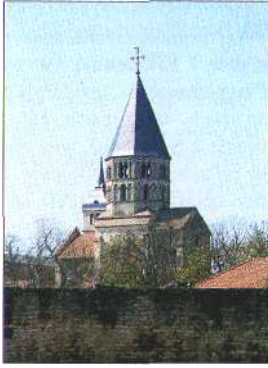
Le clocher de l'Eau bénite, seul reste de la grande église de Cluny
